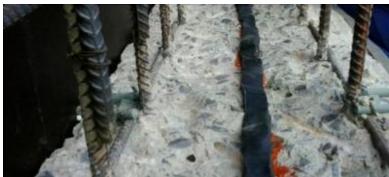
Figura 3: Perfil hidro expansivo para juntas de concretagem.
